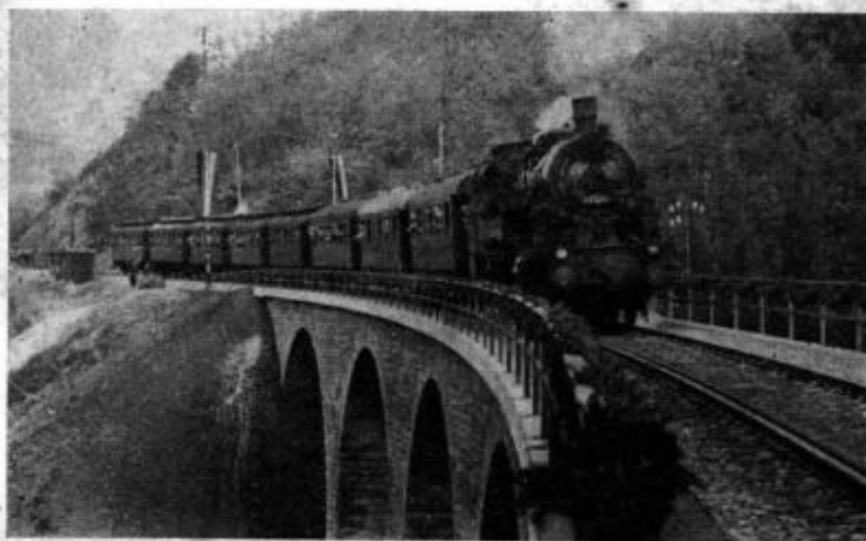
Der erste Zug fährt über den wiedererstandenen Viadukt
